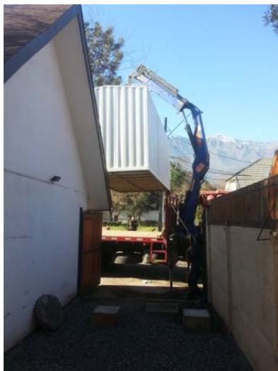
Figura 2. Instalación del container. Gentileza Cristian Gutiérrez
