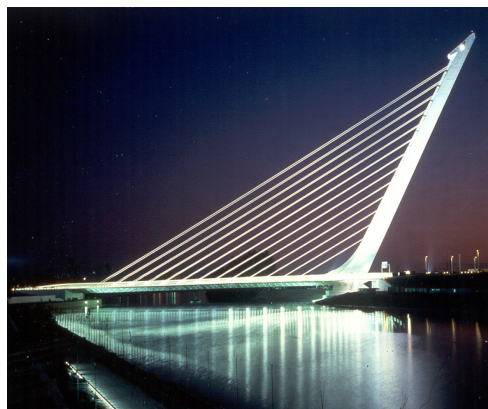
Figura 8. Puentes del Alamillo.
