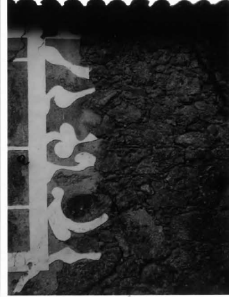
CACHOTERÍA e f. La parte externa de un muro o pared que se forma con cachotras. Constituido de una casta que se hacen con cachotras y argamasa, colocando primero las más grandes como más resistentes (cablete) encostada, la que se hace con recibo exterior y luego se blanda con cal. Estas encostadas se aprovechan a veces para pintar figuras de carácter popular.
