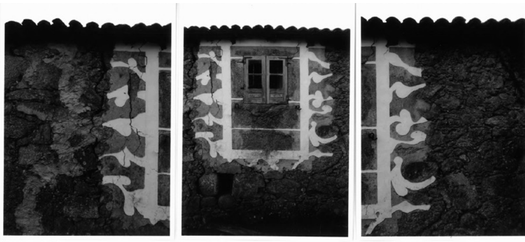
CACHOTERÍA es la parte exterior de un muro o pared que se forma con cachote. Constituido de una capa que se llama capa cachotera y argamasa, cobrotado primero por una gruesa capa de yeso (revestido) y Calabrota encastada, la que se hace con revoco exterior y luego se blanquea con cal. En la actualidad se aprovecha a veces para diseñar figuras de carácter popular.
