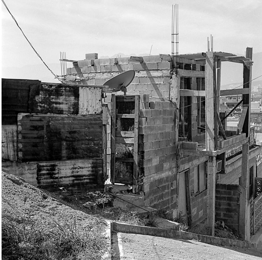
Imagen 4: La arquitectura de autoconstrucción del lugar utiliza principalmente los materiales que se extraen de las pedreras. Colonia Tierra y Libertad, cerro del Topo Chico, 2019.
