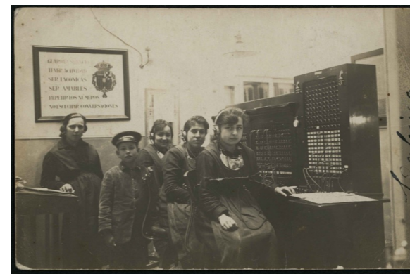
Fig. 3: Centro telefónico de la Compañía Peninsular de Teléfonos en Villafranca, 1920. Archivo histórico de Fundación Telefónica.
