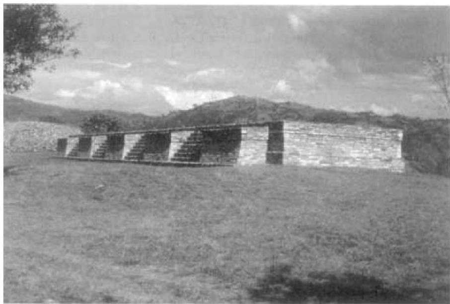
FIGURA 4.—Edificio largo en la Plaza A de Mixco Viejo.
