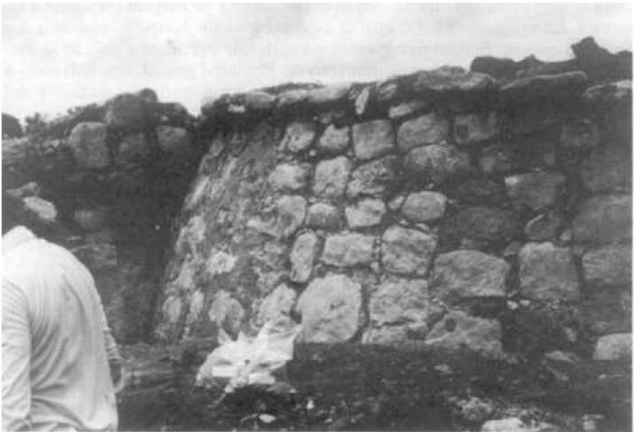
FIGURA 10.—Muro circular de la estructura DZ-12.
