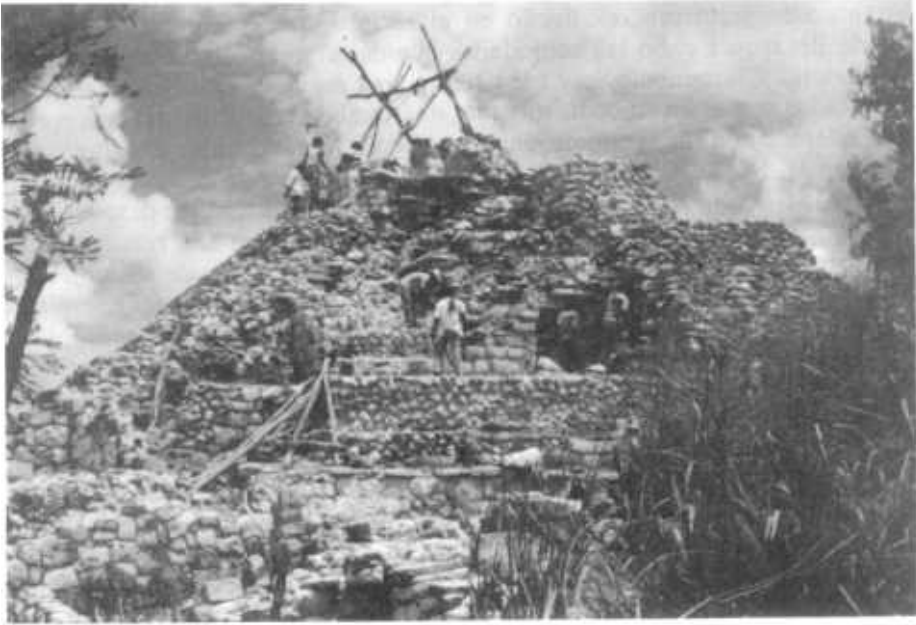
FIGURA 6. La pirámide MA-1 durante los trabajos de excavación.
