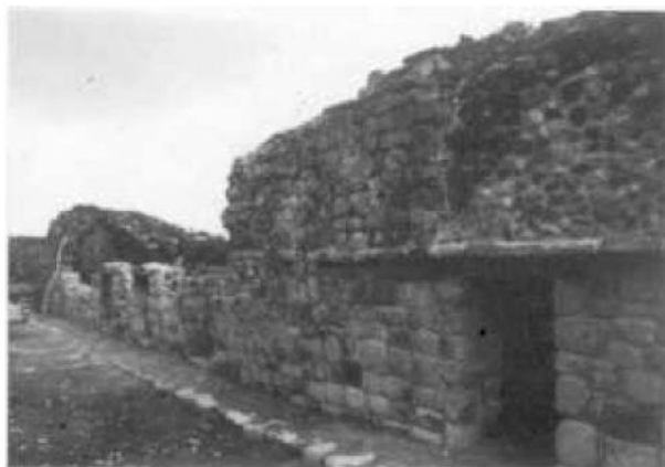
FIGURA 9: Fachada Norte de la estructura CA-6.
