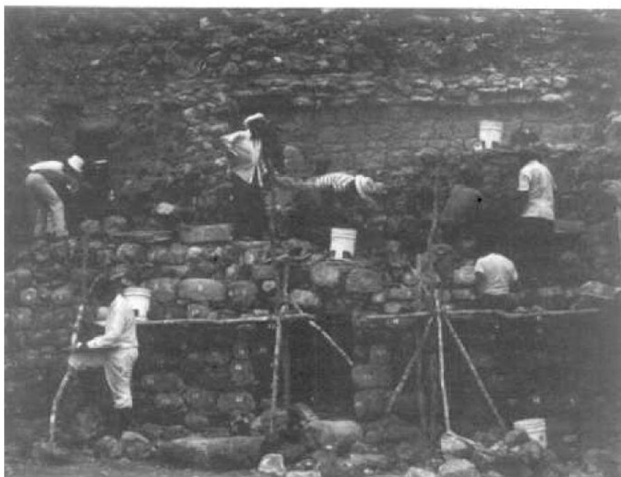
FIGURA 16: Trabajos de restauración en la fachada occidental del Satunsat.
