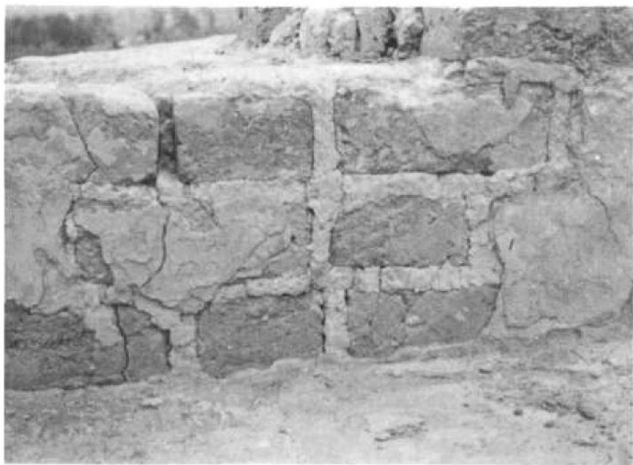
FIGURA 2.—Aspecto de la construcción de un muro con adobes con su pasta de unión y «enfoscado».
