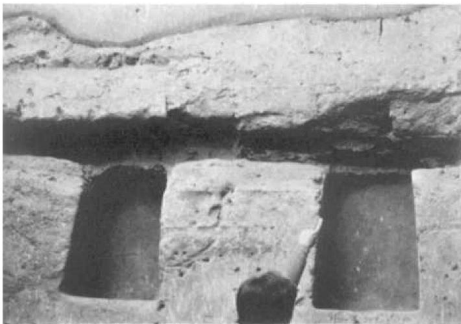
FIGURA 5.—Nichos donde se observan las vigas de madera transversales, que utilizaban de soporte para los adobes.
