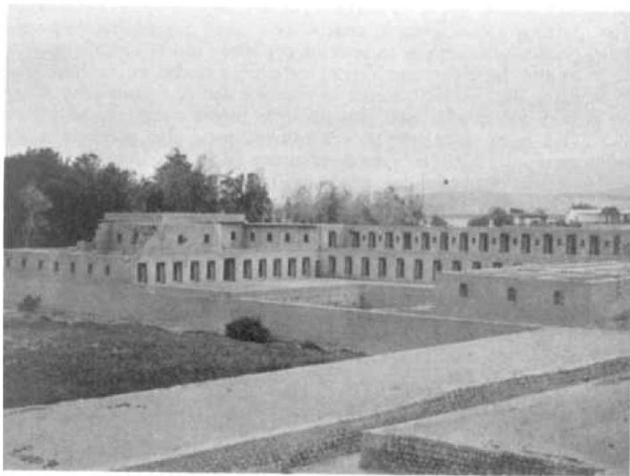
FIGURA 3.—Vista general de la parte más reconstruida del poblado, correspondiente a la «Mamacuna».
