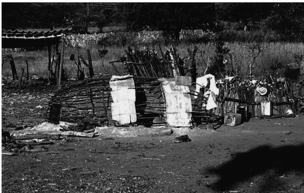
**Figura 9:** Baño de vapor provisional, evidentemente construido para más tiempo, con una fuerte armadura de ramos en Santiago Tetla, Puebla (Foto: E. Seele 1969)
