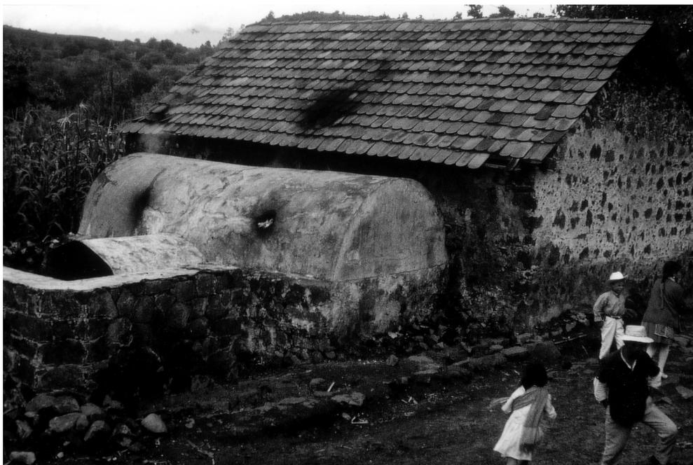
**Figura 8:** Baño comunal de Santiago Xalitzintla (Puebla), localizado en la parte más alta de la región de estudio, a aproximadamente 2.650 m de altura en la vertiente oriental del Popocatepetl, y está construido con mampostería volcánica. Desde un gran vestidor se entra en un temazcal voluminoso con bóveda de medio cañón; es calentado desde la izquierda por un túnel, protegido por una cerca. Aquí, hombres y mujeres se bañan juntos en el vapor (Foto: K. Tyrakowski 1973)
