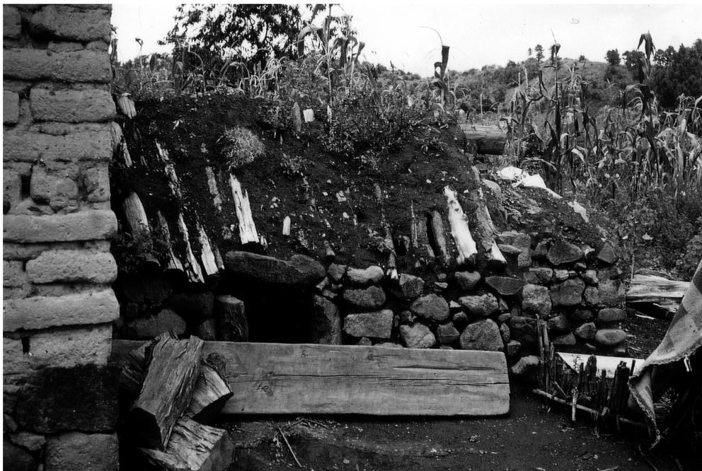
**Figura 3:** Temazcal de San Juan Ocotepéc o Cuaco (Puebla), al pie del volcán Popocatepetl; cuenta con un techo de dos vertientes cubierto de barro y con paredes de gruesos cantos rodados. Para no poner en peligro el techo, se colocó el hogar bajo una pequeña cúpula a la derecha (Foto: K. Tyrakowski 1973)
