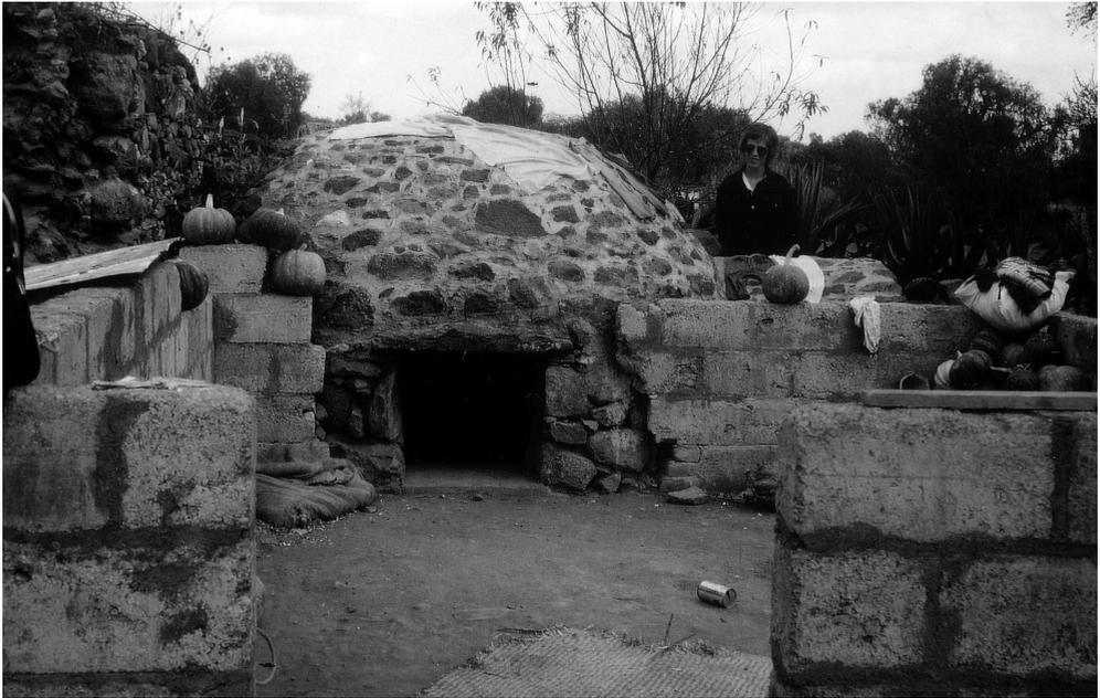
**Figura 6:** Baño de vapor en construcción en San Juan Cuautinchán (Puebla), situado al pie del Serrijón de Amozoc, en el sur: la cúpula, de la altura de un hombre, tiene la forma de un caparazón de tortuga; en primer plano se ve el vestidor en construcción. Naturalmente, la boca del hogar está a la derecha, fuera del vestidor (Foto: K. Tyrakowski 1978)
