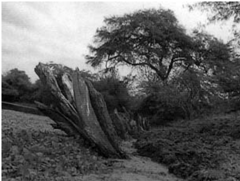
Figura 3. Muro de Albarradas reforzado con maderos de guasango. A la izquierda nótese las plantas acuáticas introducidas para oxigenar el agua.
