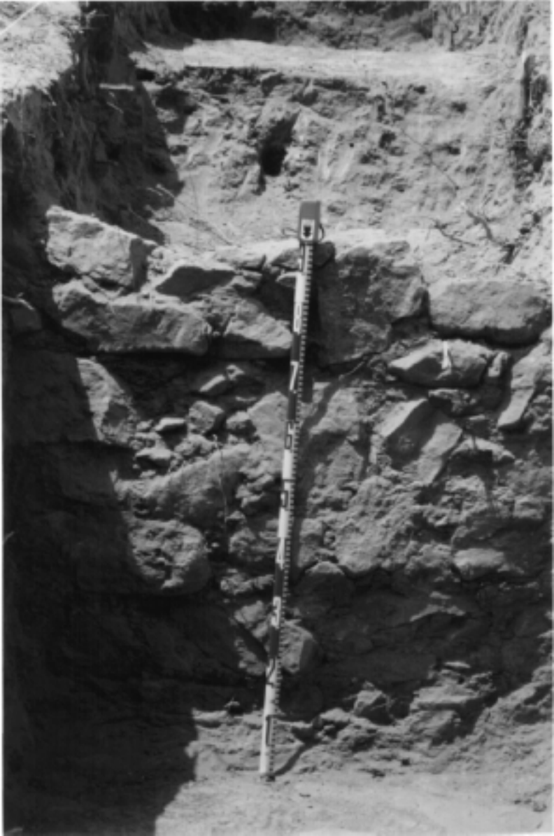
FIGURA 6.—Detalle del muro de mampostería en el sondeo estratigráfico (SE-1).
