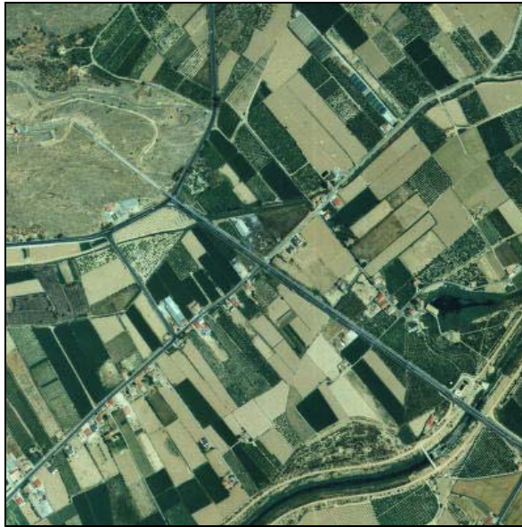
Figura 13. Fotografía aérea del sifón del postrasvase y canal de la margen izquierda a su paso por el valle del Segura en el término municipal de Orihuela. Fuente: Diputación Provincial de Alicante, vuelo fotogramétrico de 1998.
