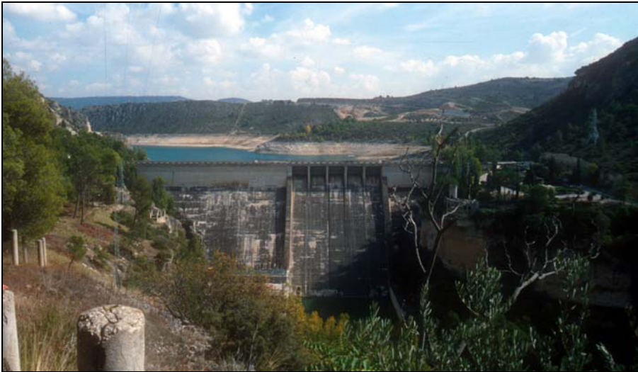
Figura 8. Embalse de Entrepeñas en el río Tajo. Vaso de almacenamiento y de regulación de las aguas del trasvase.
