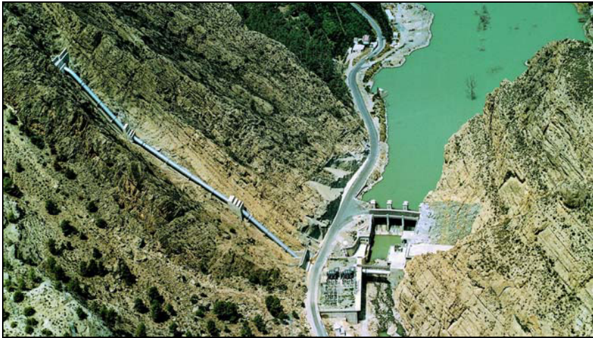
Figura 11. Detalle del Azud de Ojós, donde se derivan las aguas por los canales del postravase. La canalización ascendente corresponde al Canal de la margen derecha, que se dirige hacia Lorca y Almería. Fuente: Confederación Hidrográfica del Segura.
