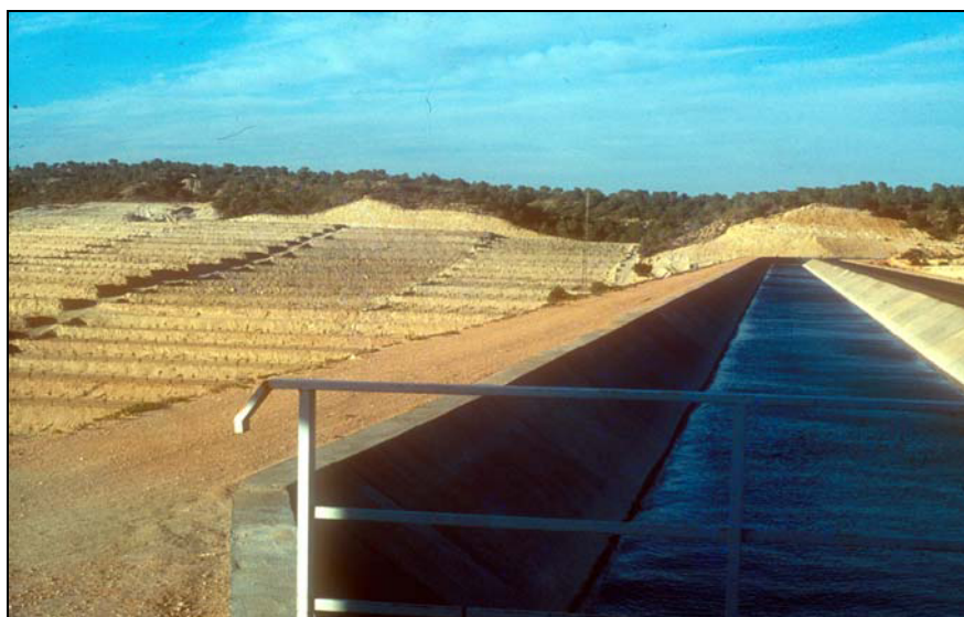
Figura 15. Canal de la margen izquierda del acueducto del postrasvase. Por encima del canal del postrasvase se observa el proceso roturador que tuvo lugar a principios de los años ochenta mediante la utilización de técnicas de aterrazamiento.
