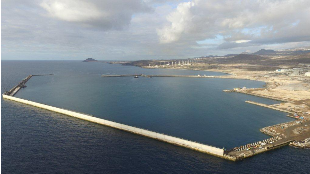
Imagen 2. Visión Norte del estado de las obras del puerto de Granadilla en enero de 2017
