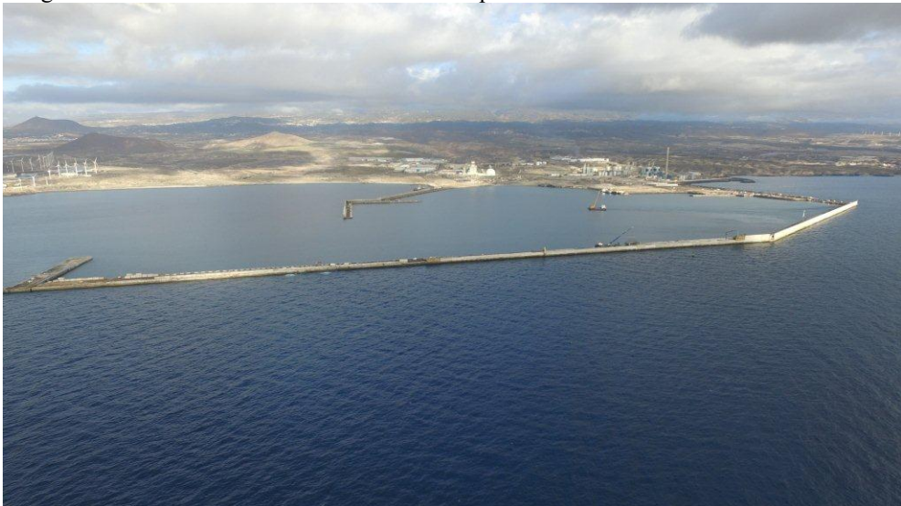
Imagen 3. Visión Sur del estado de las obras del puerto de Granadilla en enero de 2017
