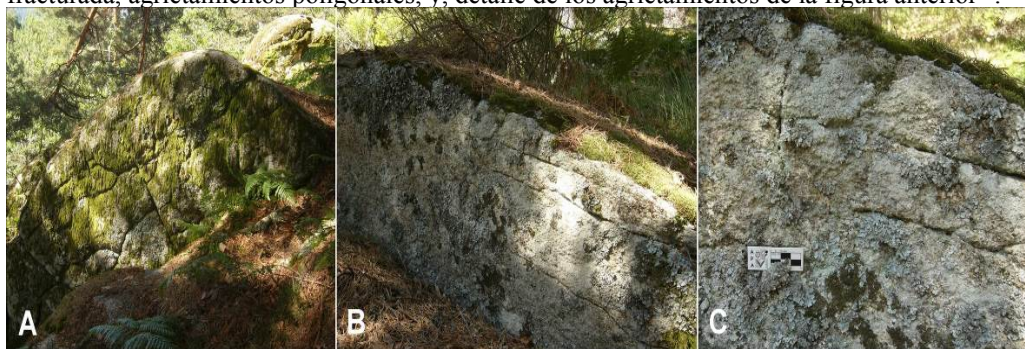
Figura 16. A) Agrietamientos poligonales desarrollados sobre una superficie granítica fracturada, agrietamientos poligonales, v. detalle de los agrietamientos de la figura anterior 32 .
