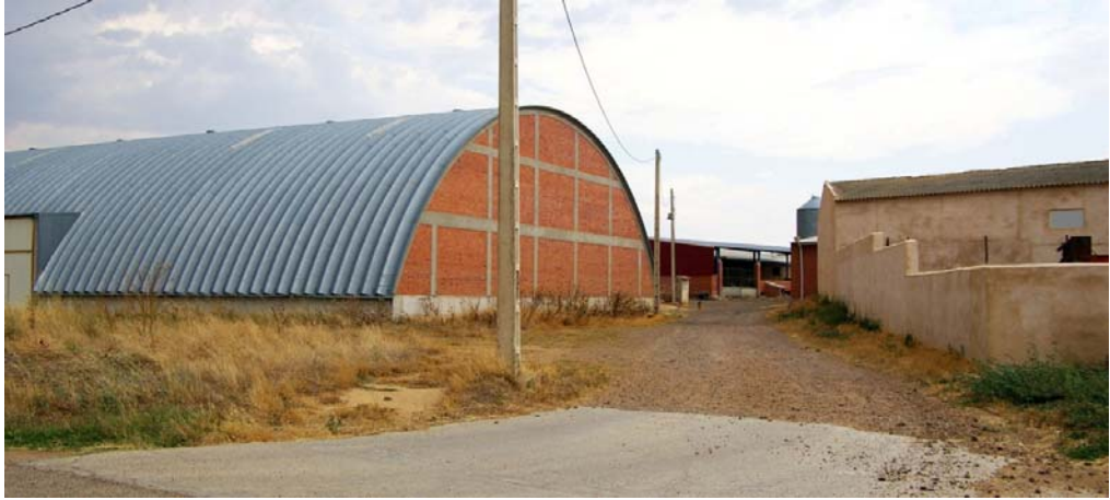
Figura 9. Nave agrícola en el núcleo de Bolaños de Campos.
