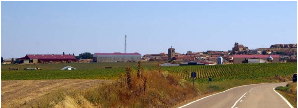
Figura 8. Vía de acceso al núcleo de Aguilar de Campos, con presencia de naves agrícolas.
