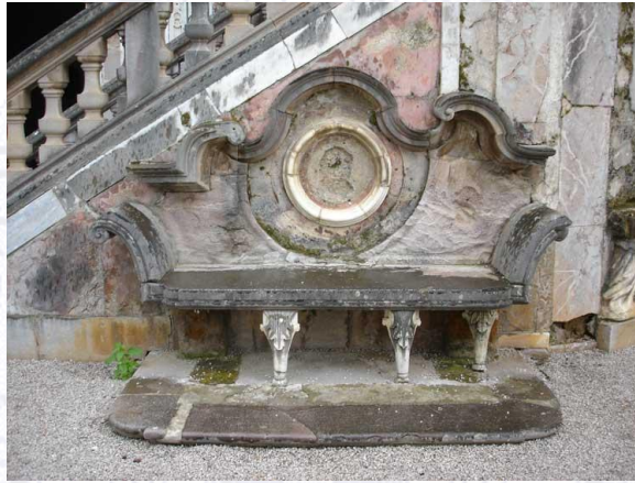
Villa Palagonia. Detalle del banco barroco de forma quebrada
