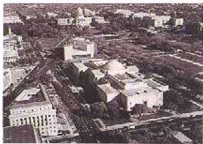
Vista aérea del edificio de Pope y la ampliación de Pui.
