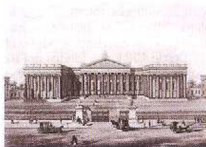
Perspectiva del pórtico de acceso.
