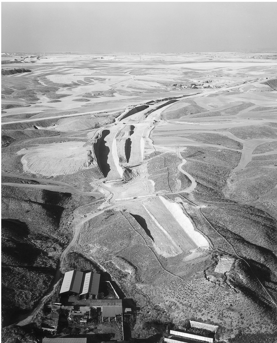
FIG. 2.—Los diferentes trabajos de fortificación que se llevaron a cabo a finales de 1936 son visibles en la imagen, una línea de trincheras en la que se van abriendo puestos de tirador, nidos de ametralladora y puntos de observación.
