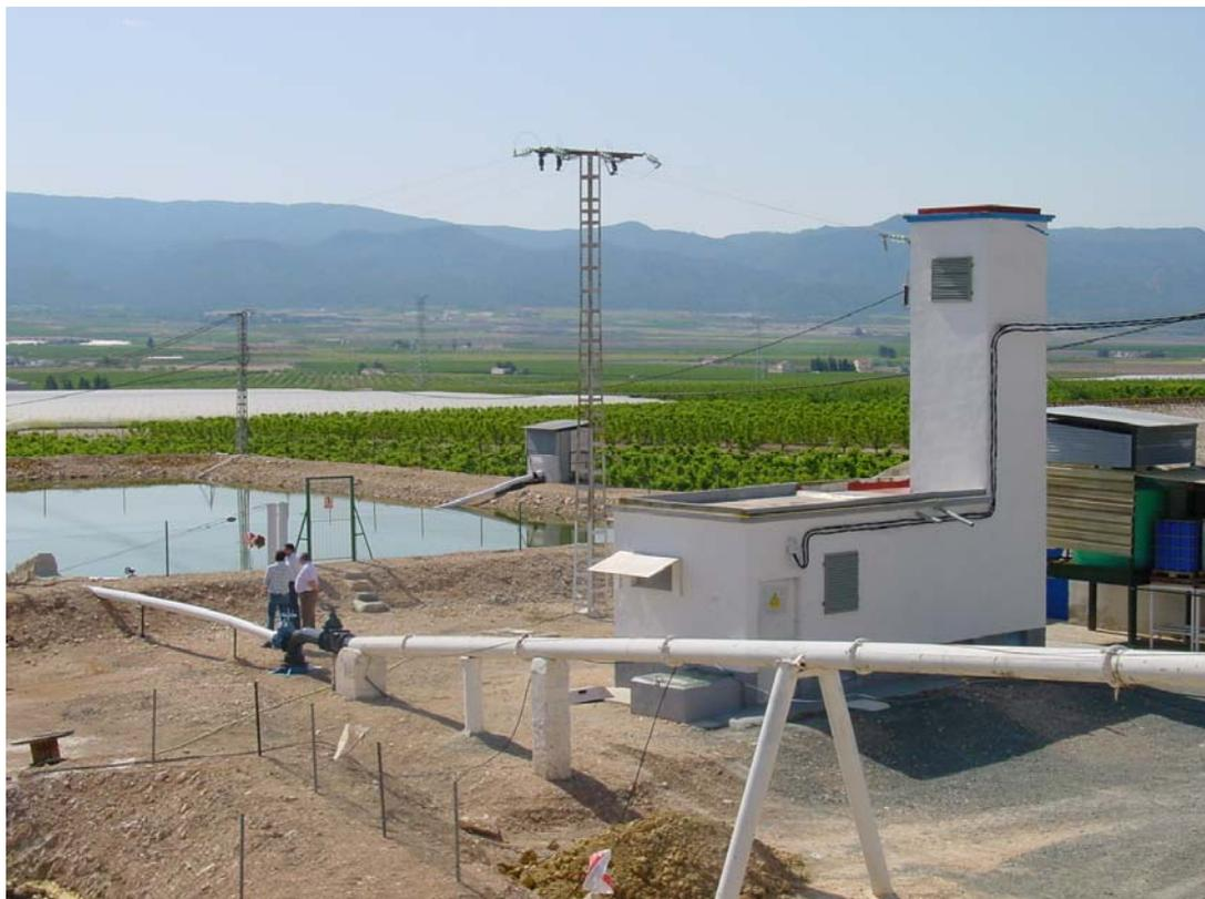
Foto nº 6. Transformador y derivación de las aguas extraídas hacia los embalses de almacenamiento, para su posterior distribución a las parcelas mediante riego localizado
