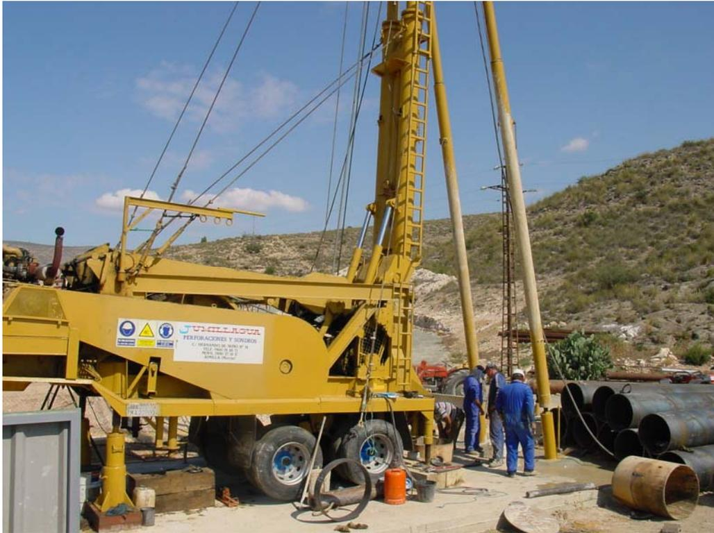
Foto nº 5. Realización de un sondeo para extraer agua en el acuífero Ascoy-Sopalmo
