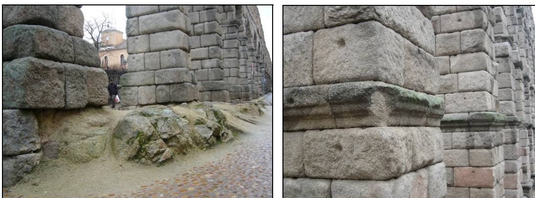
Figuras 5 y 6. Detalle del grado de meteorización de la roca sobre la que apoya el acueducto de Segovia. Detalle de bloques de granito del acueducto.
