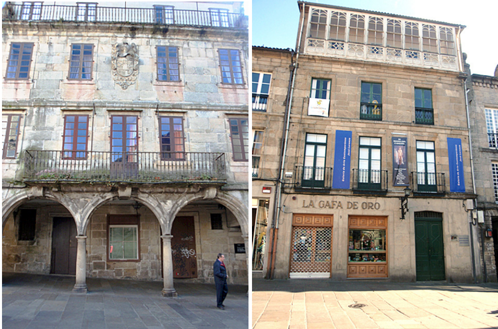
Figura 5: Edificio solariego en Cantón do Tourel y Galería de Arte Contemporáneo José Lorenzo, en la praza do Tourel. Fuente: María Sotelo Pérez (2012)
