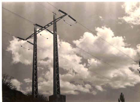
Figura 9.- Piedad Isla, Guardo, Unión Española Explosivos, Instalaciones eléctricas.
