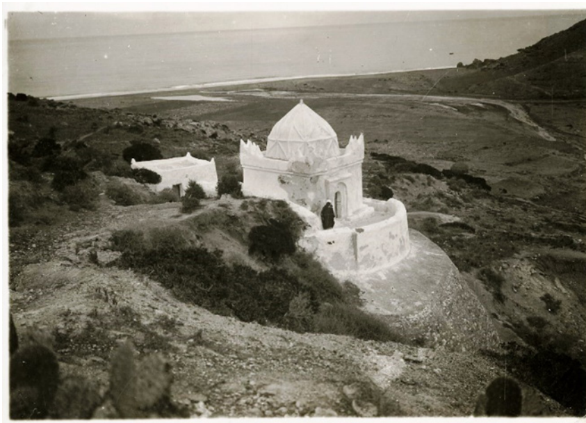
Figura 5. Morabo de Sīdī Mesana en la costa mediterránea. El edificio principal luce los cuatro merlones esquineros típicos y la falsa cúpula. En segundo plano el edificio auxiliar vivienda del pariente heredero y guarda, que posa a la puerta de aquél
