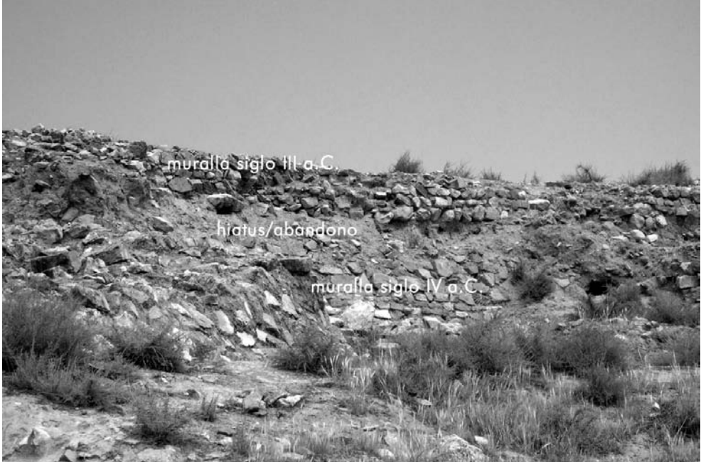
Fig. 6. Sector meridional de la muralla de Puente Tablas. Niveles constructivos.
