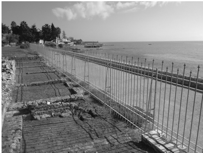
Figura 2. Restos de las tabernae romanas que se abren al cardo XVIII, cuyo trazado queda ya fuera del recinto del Parque Arqueológico del Barrio de Magón (fotografía del autor, 2017)
