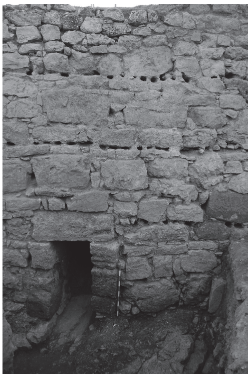
Figura 2. Salida de la cloaca principal de la ciudad al exterior de la muralla. Obsérvese los agujeros conservados para la colocación de un andamio.
