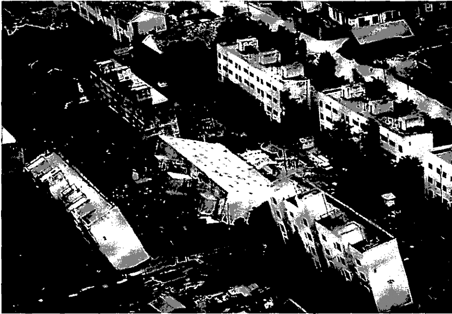
Figura 1. Licuación de cimentaciones en Niigata.
