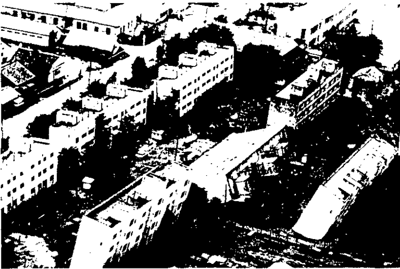
Figura 3. Efectos del terremoto de Niigata de 1964 producido por fallo del terreno.
