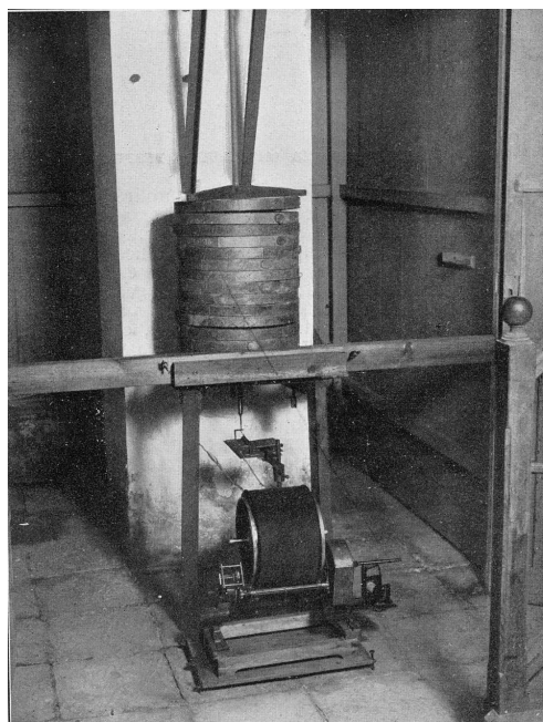
PENDULO VERTICAL GRAÍÑO DE 700 KILOGRAMOS DE MASA, DE OBSERVATORIO DE MARINA DE SAN FERNANDO
