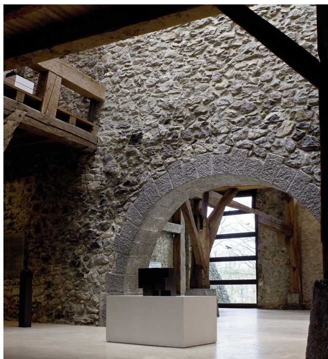
Fig. 10. Iluminación del muro divisorio a través de un recorte en el forjado de la primera planta. Foto: Alberto Cobo
