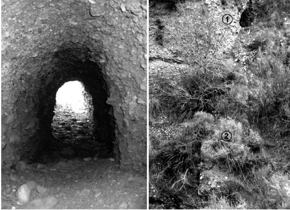
Fig. 8. Restos de galería hidráulica (1) y del estribo (2) de una presa o alcantarilla en el Barranco del Aljibe de la Lluvia o del Conejo.
