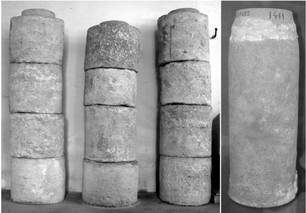
Fig. 1. Encañados de piedra (diámetros entre 45 y 48 cm) y atañor cerámico (diámetro 10 cm) pertenecientes a los sifones de la Almunia de los Alijares.
