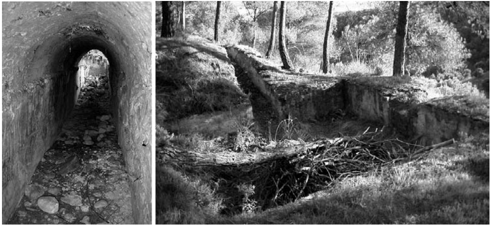
Fig. 4. Galería hidráulica que prolongó los canales de Beas y Aguas Blancas desde el Hoyo de la Campana hasta el Barranco Bermejo. Alberca emisaria donde finaliza su trazado.
