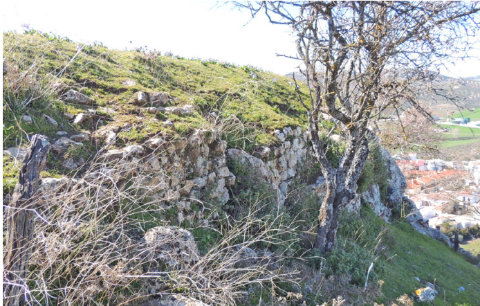
Figura 7. Alzado del tramo mejor conservado en el ángulo SO del recinto.
