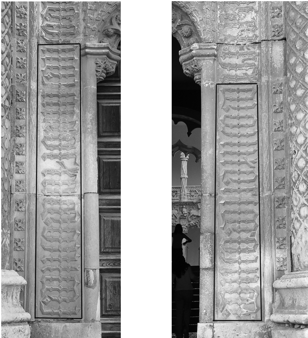
Detalle de las partes reconstruidas (en recuadro)
