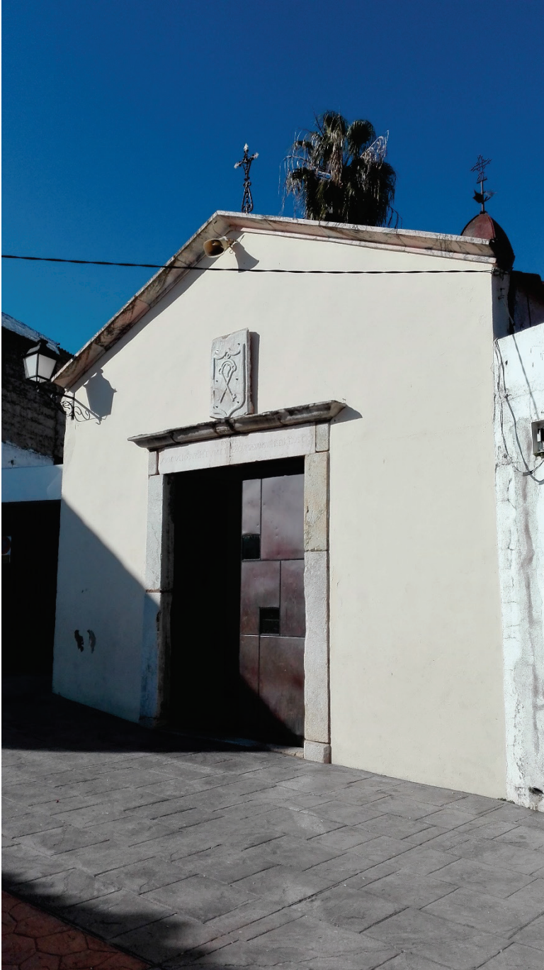
Figura 5. Vista de la portada de la Ermita del Cristo de la Misericordia.
