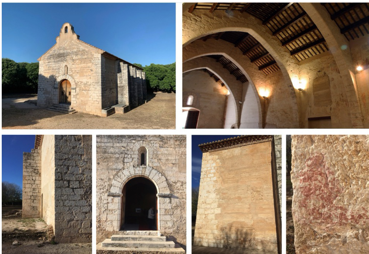
Fig. 2. Vista general y detalles constructivos de la ermita de Sant Roc de Ternils. [Superior] Vista frontal e interior con sillería en los contrafuertes, tapia en los paramentos y arcos de diafragma; [Inferior] Esquinas con sillería; portada; paramento de tapia reconstruido; y superficie pétreo con huellas de talla y restos de un enjalbegado rojizo. Fotos: los autores.
