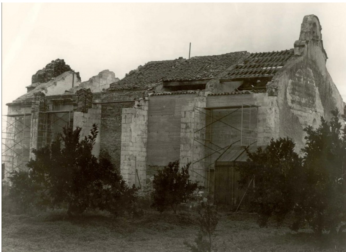
Fig. 4. Ermita de Ternil durante los trabajos de restauración iniciados en 1980. Foto: Daràs, La Mare de déu de la salut , 143.
