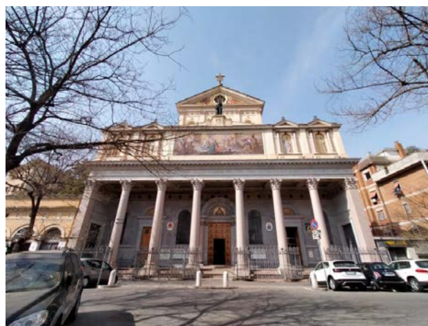
Fig. 13. Chiesa di San Giocchino in Prati, facciata (foto di Valentina Angela Cumbo)
