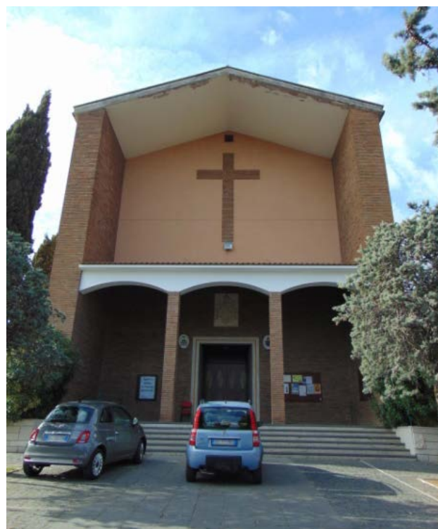
Fig. 9. Parrocchia di San Girolamo a Corviale, facciata (foto di Cristina Cumbo)
