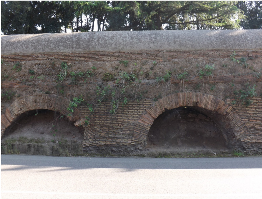
Fig. 1. Roma, Via Aurelia Antica. Parte dell'acquedotto Traiano-Paolo verso il lato di villa Pamphilj in prossimità dell'entrata al civico 183. Foto: Cristina Cumbo
