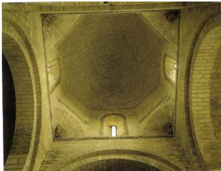
Fig. 12. Interior, cúpula sobre el crucero (Archivo de la Fundación Santa María la Real). Imagen tomada de VV.AA 2004a.
