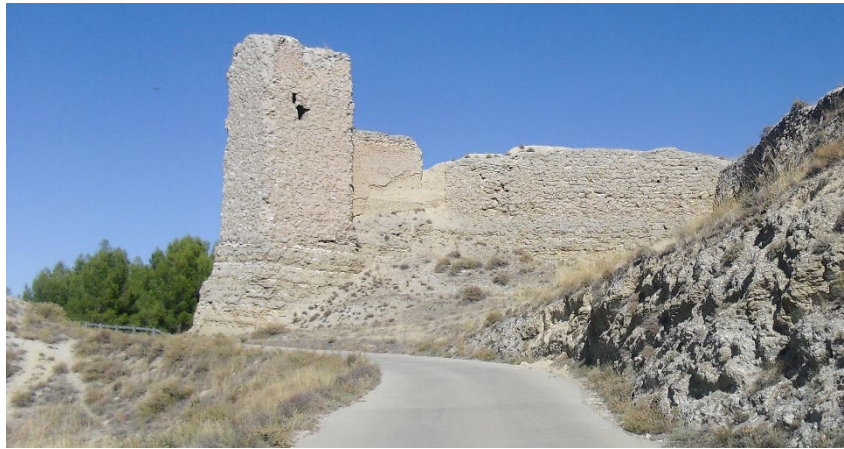
Fig. 11. Torre albarrana, sector norte del conjunto amurallado (s. IX).
