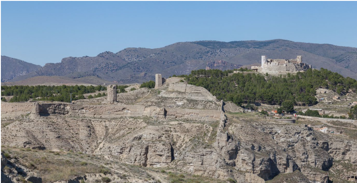
Fig. 16. Vista general de los sectores norte y occidental del conjunto fortificado de Calatayud, en el que se identifican la Torre Mocha, el Castillo Mayor, la torre albarrana y diferentes lienzos de muralla (s. IX y X).
