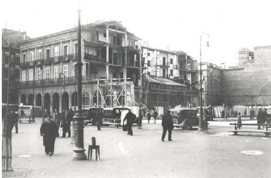
Figura 27. Reformas en el edificio del Crédito Navarro tras el derribo del Teatro Gayarre. Julio Cía. 1934. Archivo Municipal de Pamplona. Fototeca.
