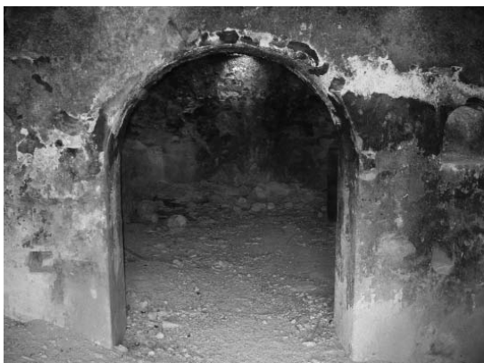
Figura 14.- Interior del Fortín 1 de El Espartal (Valdemoro).
