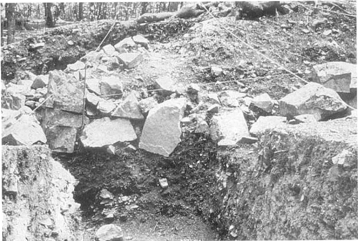
Lám. 17. 1: Muro descubierto por J. G. Bulliot en el Porrey. 2: Detalle de dicho muro pseudo-ciclópeo redescubierto en la vertiente Oeste.
