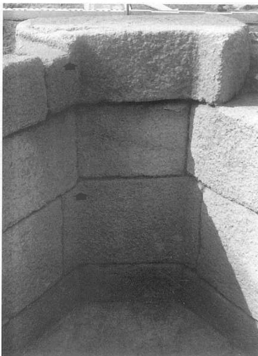
Lám. 24. 1: Resalte de la segunda hilera sobre la primera a causa de un defecto en el control del trazado de las aristas superiores. 2: Angulos de encaje en los bloques del extremo Sur que demuestran el ajustado in situ de los lechos de asiento. (Fotos Beuvray)
