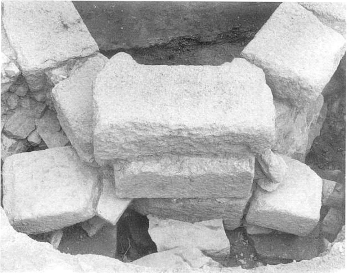
Lám. 12. 1: Vista vertical del extremo Sur del Estanque y de la trinchera de fundación. 2: Detalle de la disposición de los sillares y bloques situados en el extremo Sur de la trinchera de fundación. (Fotos Beuvray).
