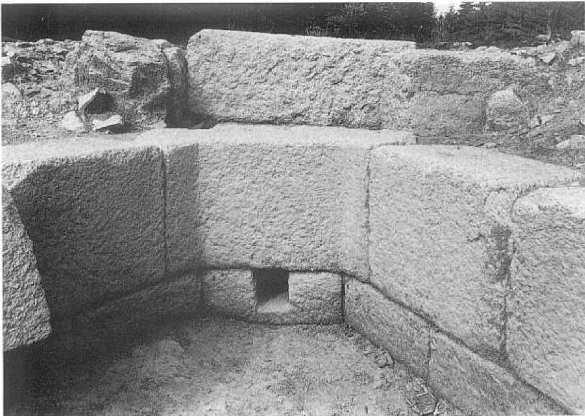
Lám. 7. 1: Detalle del extremo Sur del Estanque, en el que se aprecian los entalles de ajuste de los sillares. 2: Detalle del chaflán Norte del Estanque con el desagüe. (Fotos Beuvray).
