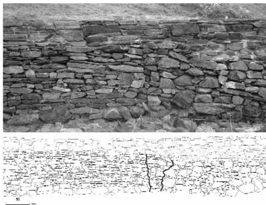
Figura 7.- Encaje entre los muros de la estancia principal del monumento y los localizados al sur de ella (en la parte inferior se marcan la unión entre los muros y el aparejo que rellena la unión; en claro y punteado, hiladas añadidas en la consolidación).
