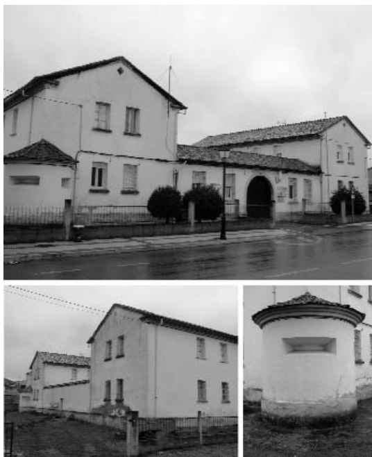
Figura 7.- Casa-cuartel de la Guardia Civil en A Pobra de Brollón.
