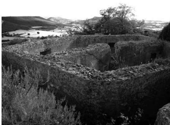
Figura 7.- Elemento de resistencia de hormigón, ejército nacional. Guadalajara.
