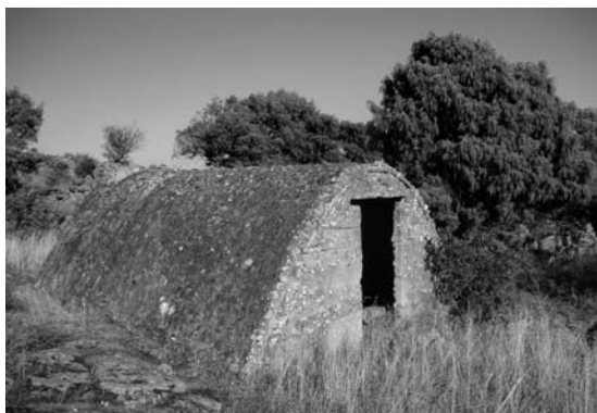
Figura 12.- Vivienda catenaria del despliegue nacional junto al río Perales (Navalagamella).
