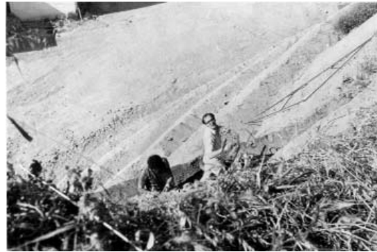
Lámina I.- Vista tomada desde el reborde del Cabezo de San Pedro en 1969, donde se observan los trabajos de desmonte, situado en el límite donde se unía con el Cabezo del Cementerio Viejo, desmontado en el siglo XIX.
