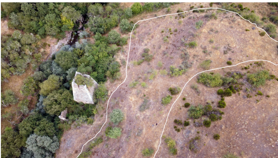
Figura 5. Imagen aérea del horno alto de la ferrería de Huerta de Abajo, junto al río Tejero y al pie del cerro de La Cabeza. A la derecha de estas instalaciones, y delimitado por un línea blanca, se aprecia un gran acopio de escorias de reducción de hierro recolectadas en el castro para su refundición
